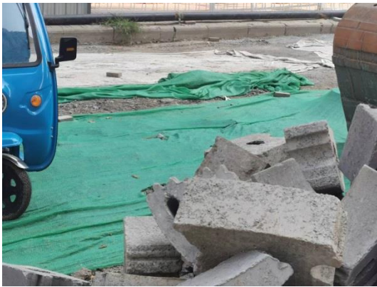
管沟施工阶段临时苫盖
