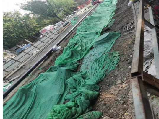
管沟施工阶段临时苫盖
